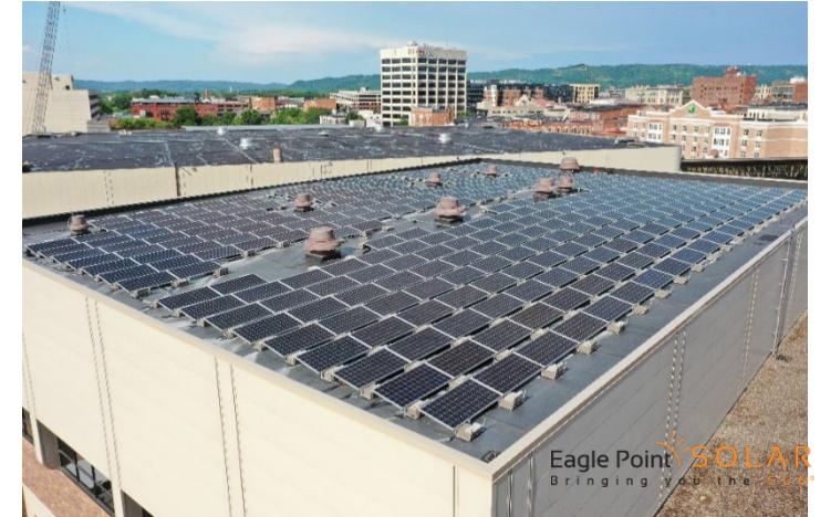
La Crosse Center: 100 kW
