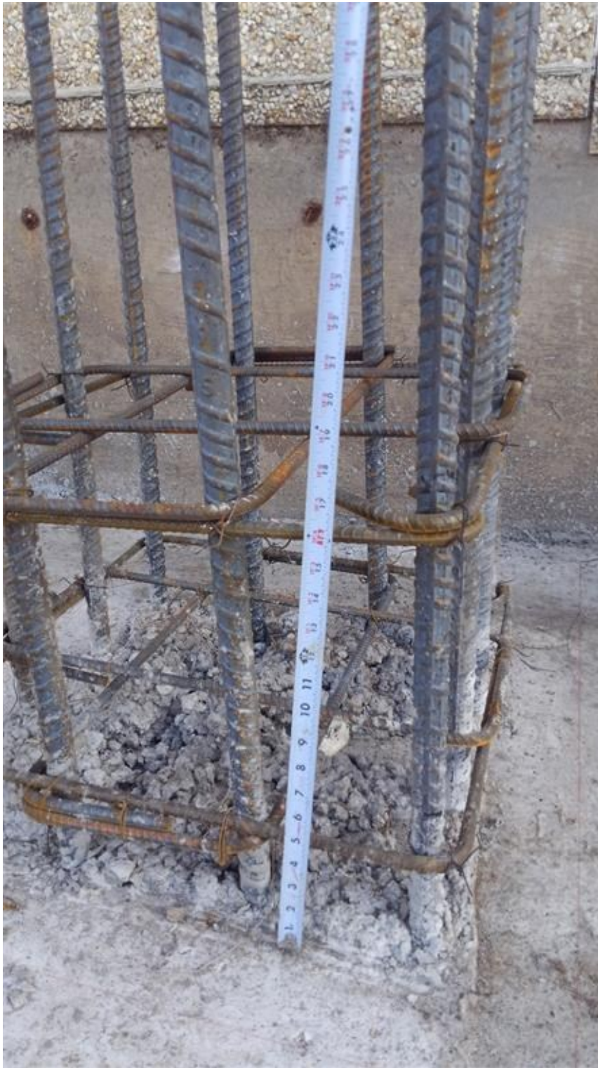
First 2' pour of column at 14/E
