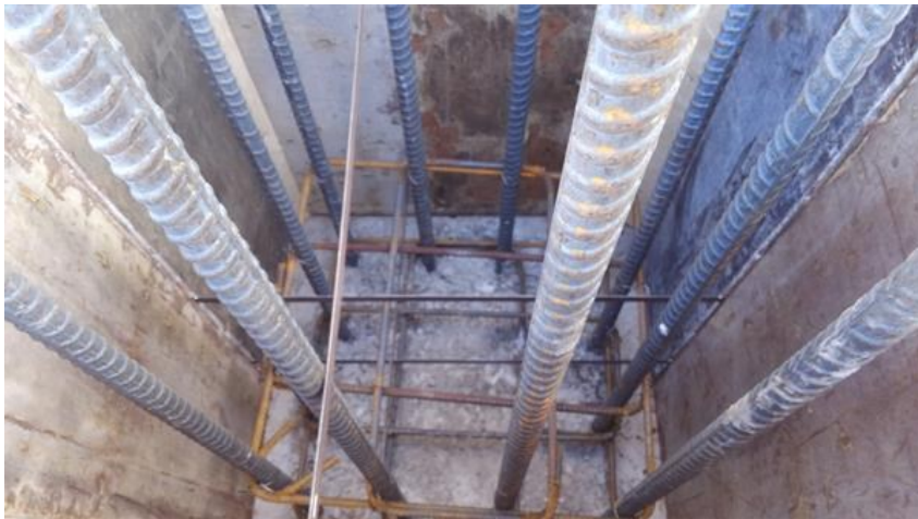
First 2' pour of column at 15/E
